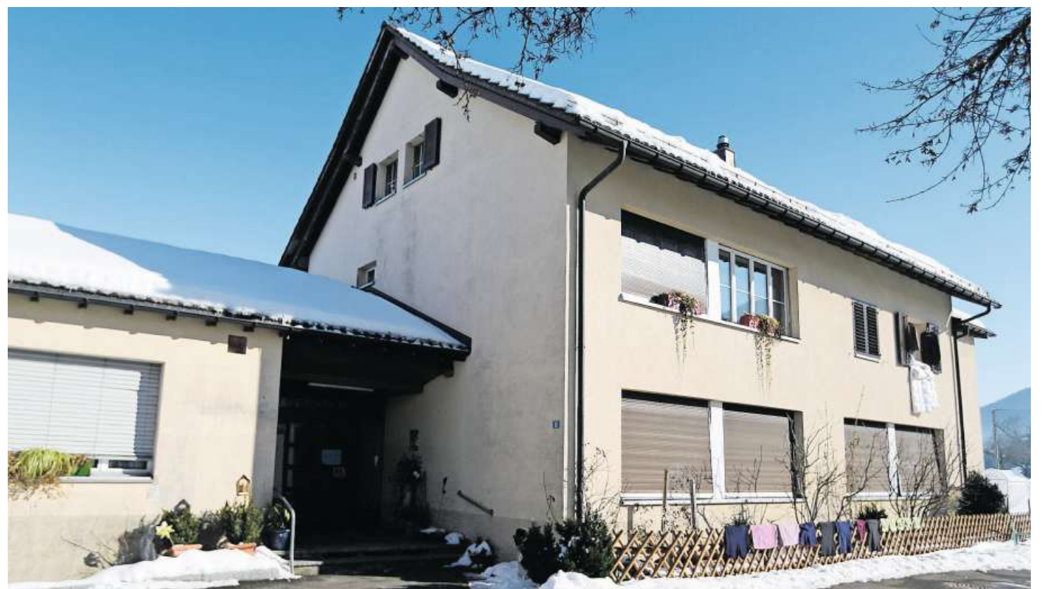
Das Schulhaus Finstersee mit Baujahr 1949 soll saniert werden und einen Neubau erhalten.
